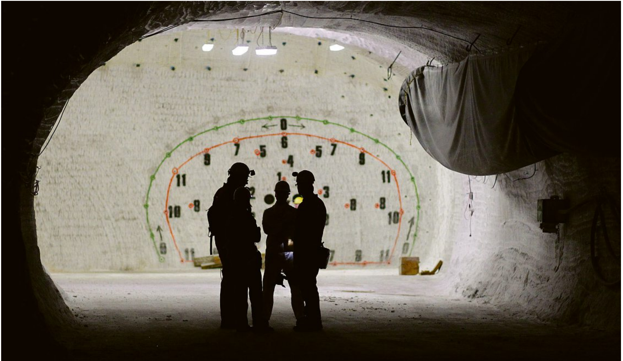
Ein Seitenstollen im Erkundungsbergwerk Gorleben. Jahrzehntlang wurde geprüft, ob sich der Salzstock für die Endlagerung von hoch radioaktivem Atom Müll eignet. Inzwischen ist Gorleben als Endlager ausgeschlossen. KAY NIETZELD/DPA
